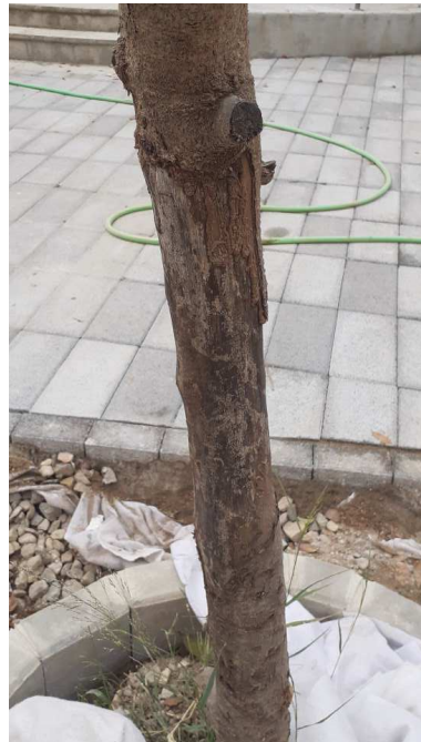
Anillado por descortezamiento, seguramente por vandalismo.
