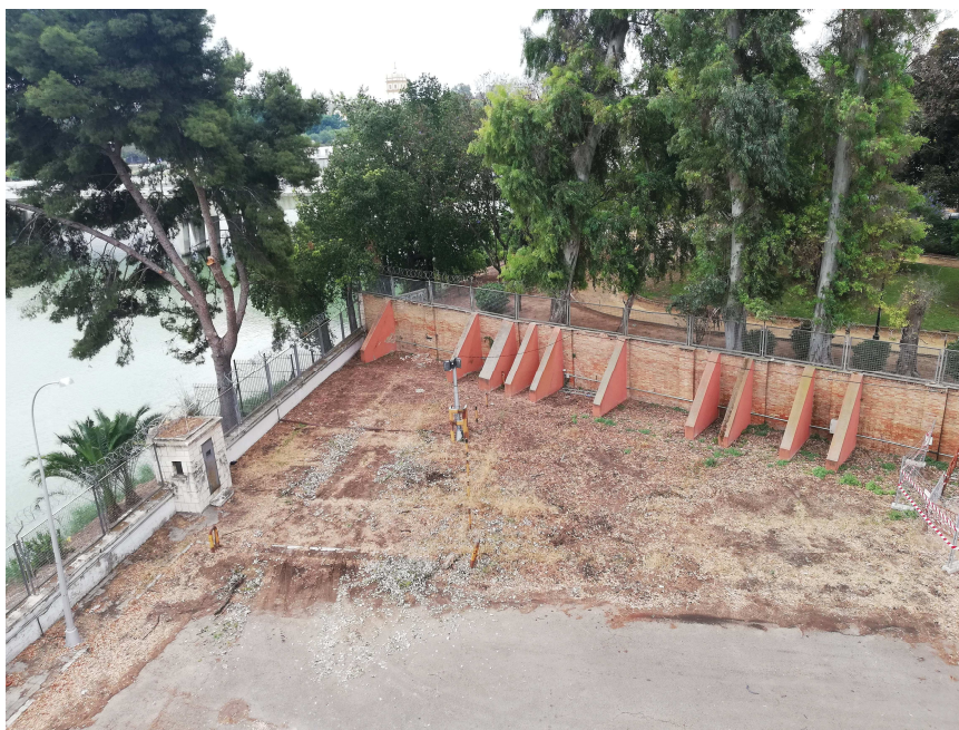
Vista general del muro existente con contrafuertes, que deben eliminarse para la ejecución de la obra prevista.
