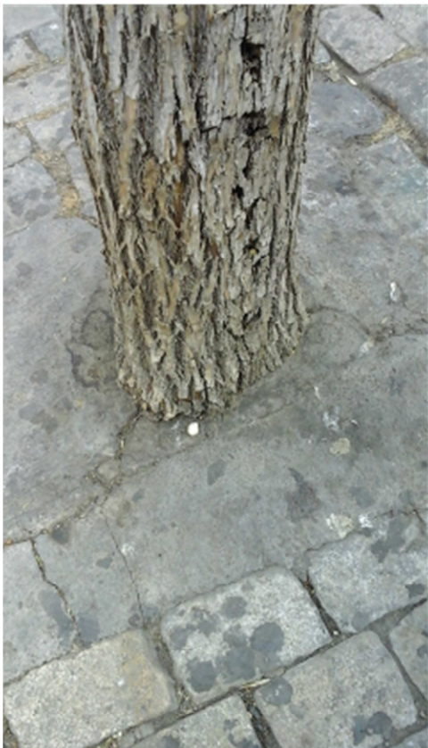
Detalle alcorque cegado con adoquines y cemento: anillamiento del tronco y posible anoxia radicular.
