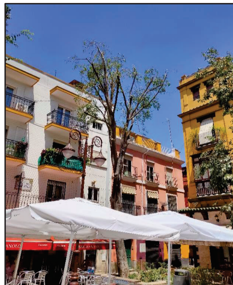
3. Vista general de la posición después de la reducción de copa severa
