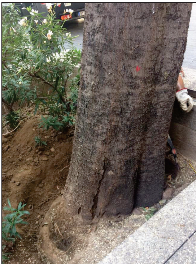
6. Vista general de la zona con los defectos presentados
